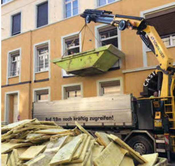
Bauschuttentsorgung mit Kran
